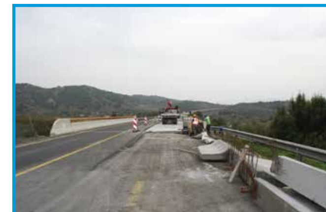
Слика 2. Орапавување на коловозот со стругање Извор: Сопствена слика
