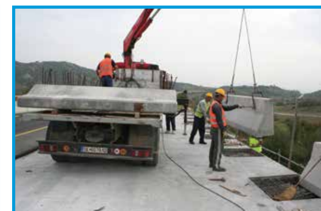
Слика 3. Поставување на одбојна ограда тип „Њу Џерси“ Извор: Сопствена слика
