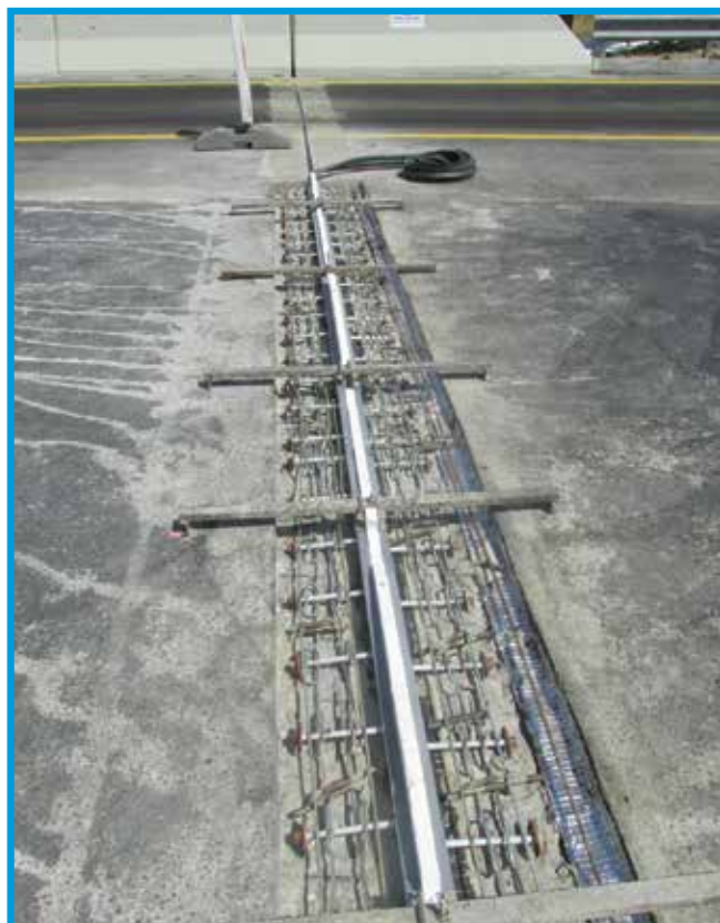
Слика 4. Санирање на дилатациона фуга Извор: „Freyssinet“ Македонија
