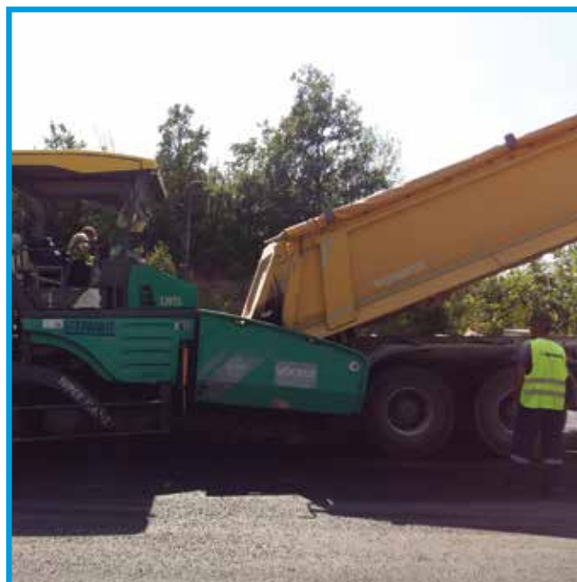
Слика 4. Асфалтирање на завршниот асфалт бетонски слој Извор: Сопствена слика
