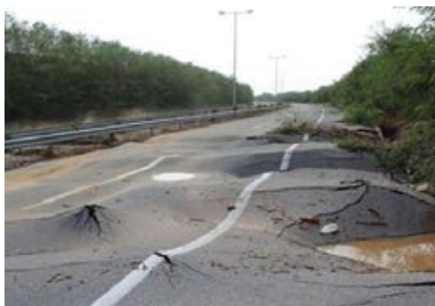
Г) Комплексно деформирање на коловоз на северна обиколницана град Скопје при поплава во 2016 година
