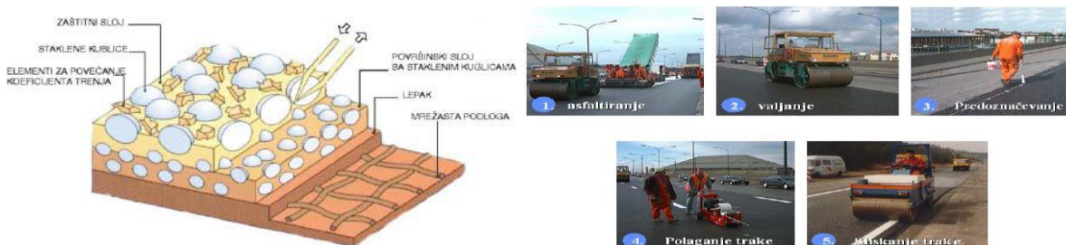
Слика 7. Поставување на надолжна ознаки на коловоз изработени со апликативна трака
