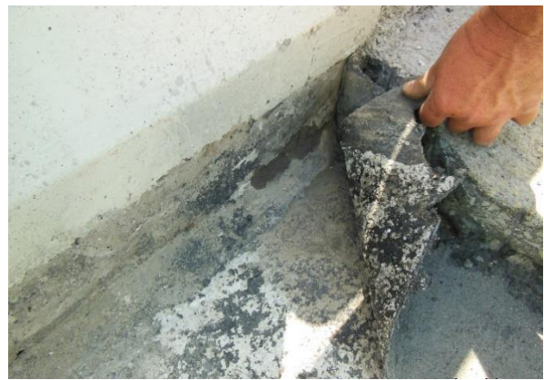
Слика 2. Цементен малтер одвоен од подлогата и залепен на битуменската лента Извор: Слика од градилиште
