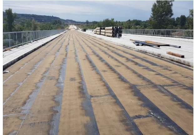
Слика 6. Заварени битуменски ленти Бикутоп П 5 мм МОСТ на мост Извор: Мост на река Сава и Колубара, Србија
