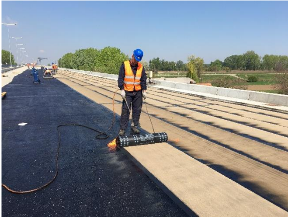
Слика 5. Заварување на битуменски ленти П 5 мм МОСТ на мост Извор: Мост Остружница, Белград
