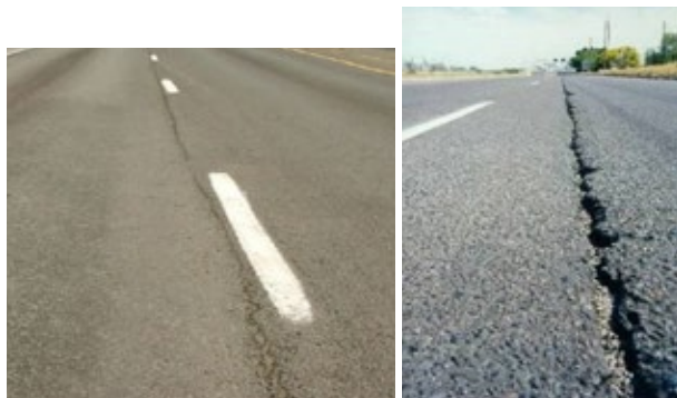
Слика 1. Лошо изведен подолжен асфалтен спој Извор: https://theconstructor.org
