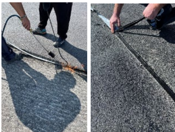
Слика 13. Бикутекс – со загревање по топла постапка
