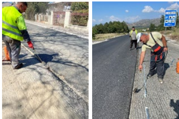
Слика 11. Загревање на исчистениот спој Извор: ул. Варшавска, Скопје, Македонија
