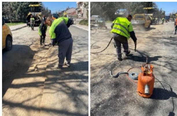
Слика 9. Сечење на асфалт кај спој Извор: ул. Варшавска, Скопје, Македонија
