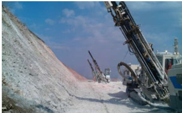
Слика 5. Поглед на процесот на дупчење на контурните дупкотини и полето со примарни и контурни мински дупки
